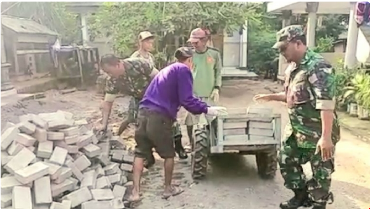
Babinsa Desa Keleyan, Koramil 0829/02 Socah saat membantu warga memperbaiki jalan Desa
